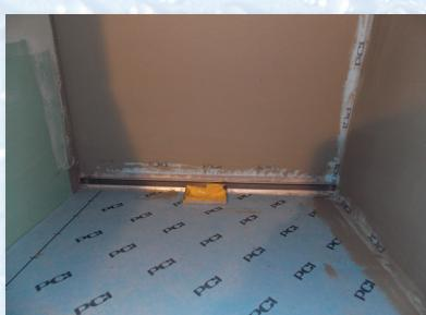
Abdichtung mit geeignetem Abdichtungsmaterialien sowie Fugenbänder durch den Plattenleger.
