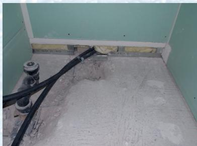
Vorwand ab fertig Boden um 8cm aussparen.
