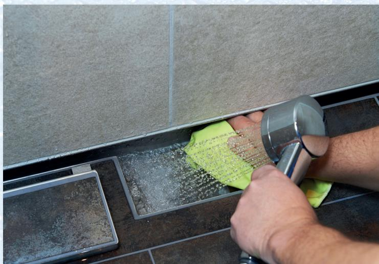
Durch den Wandschlitz von 23 mm und durch den Auslaufkasten lässt sich die Rinne problemlos von Hand ohne Spezialwerkzeug einfach und schnell reinigen.
